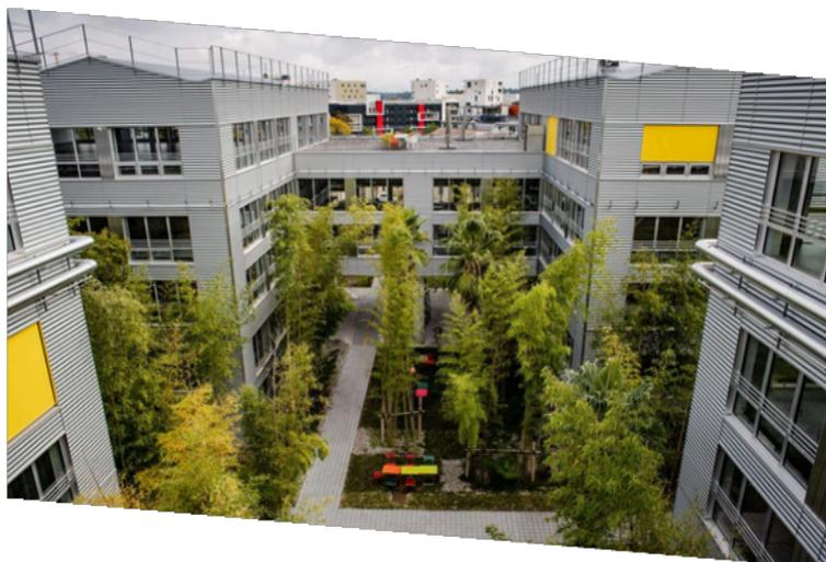
Autre référence DL Océan, avec une structure s'appuyant sur trames de poteaux béton existants, cette surélévation des 5 300 m<sup>2</sup> de toiture (+ 2 500 m<sup>2</sup> de renfort plancher) représente 800 tonnes d'acier et 120 tonnes pour le renfort plancher. Notons que la toiture de l'existant est renforcée pour permettre de l'utiliser en plancher et qu'une autre partie du bâtiment est surélevée en mixte bois métal afin d'alléger les charges sur des portées plus importantes.
